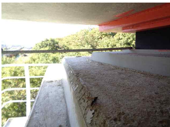
받침장치 연단거리 측정
